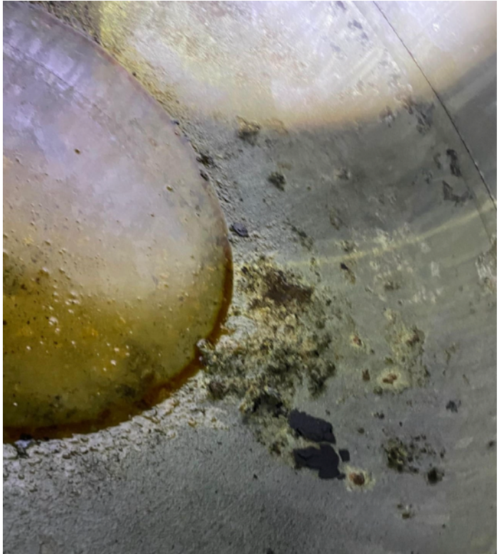
Hava Tanklarının İç Yüzeyi
