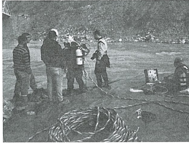
Şekil 4. Satihtan ikmelli dalış sistemi ile duvar dibinden dalmaya hazırlanan dalgıç
