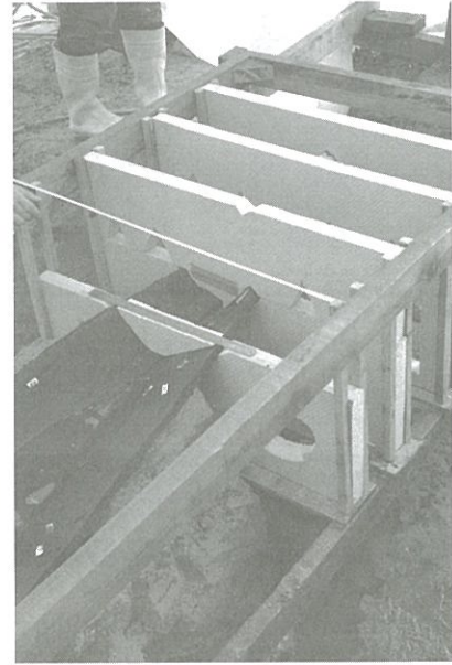
Fotoğraf 8. Kaplama tahtalarının formlarına göre ahşaptan inşa edilmiş taşıyıcılarla yerlerinden kaldırılması . Fotoğraf 9. Metro III teknesinin kütle olarak kaldırma hazırlıkları (sağ).
