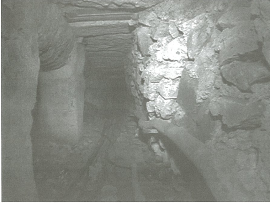
Şekil 4. Ayasofya'nın altındaki tünellerin zaman içinde değişen yapısı ve yukarıda görülen mermer döşeme
