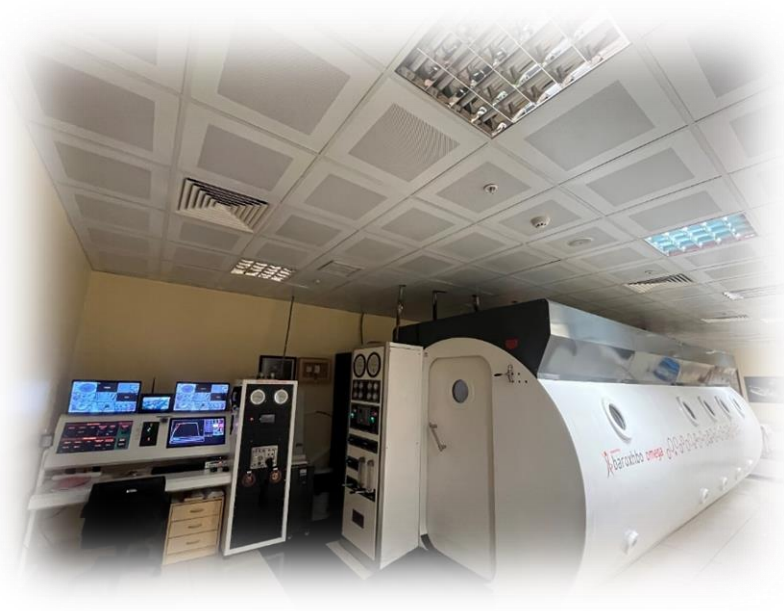
Şekil 2.2. SBÜ Gülhane Eğitim ve Araştırma Hastanesi Sualtı Hekimliği ve Hiperbarik Tıp Anabilim Dalı'nda kullanılan çok kişilik basınç odası
