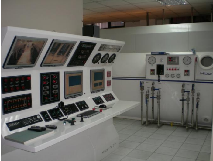
Şekil 3. Çok kişilik basınç odası kontrol paneli (İstanbul Tıp Fakültesi Sualtı Hekimliği ve Hiperbarik Tıp Anabilim Dalı)
